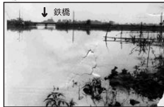
昭和 34 年 田園一面が浸水 (東古川地内)
