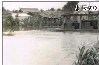
昭和 34 年 氾濫した新堀川 (河戸地内)
