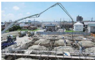
工事の様子(7/10撮影)
